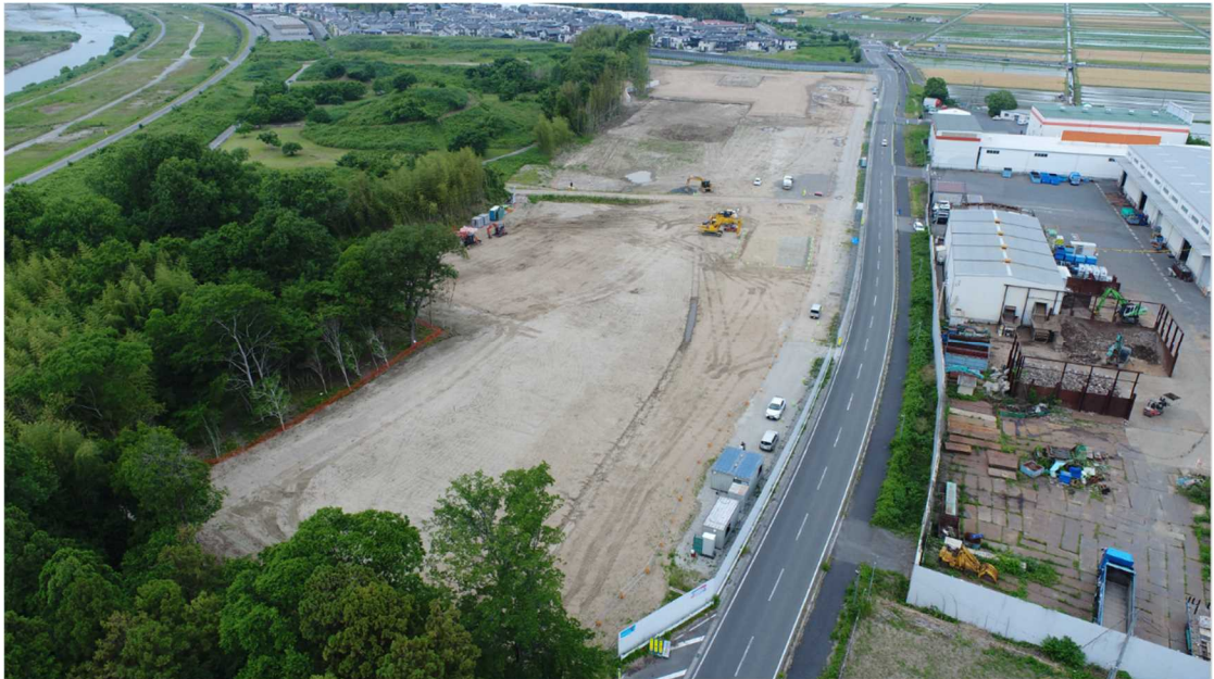
【用地整備の状況（令和7年5月29日時点）】
