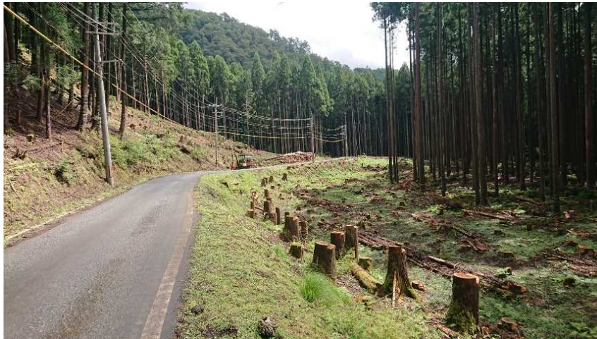
道路沿いの予防伐採を行った現場
