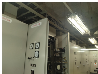
(写真4) 受変電設備
