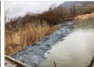
遮光シートの敷設
