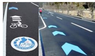
矢羽根による路面表示と案内整備
