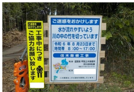
河川の維持管理工事(工事看板)
