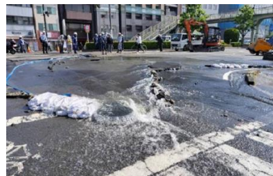
埋設管の老朽度確認へのDX活用の重要性 令和7年4月京都市下京区の水道管漏水事故（出典：国土交通省資料）
