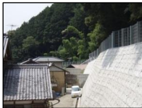
(急傾斜地崩壊防止施設)
