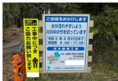
河川の維持管理工事(工事看板)
