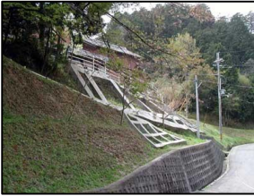
(急傾斜地崩壊防止施設)
