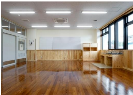
内装の木質化(草津養護学校)
