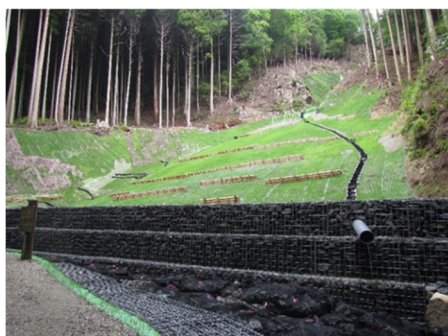
治山工事(木柵工・木筋工)
