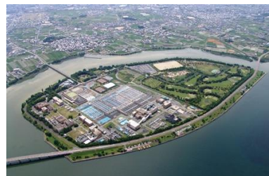
湖南中部浄化センター
