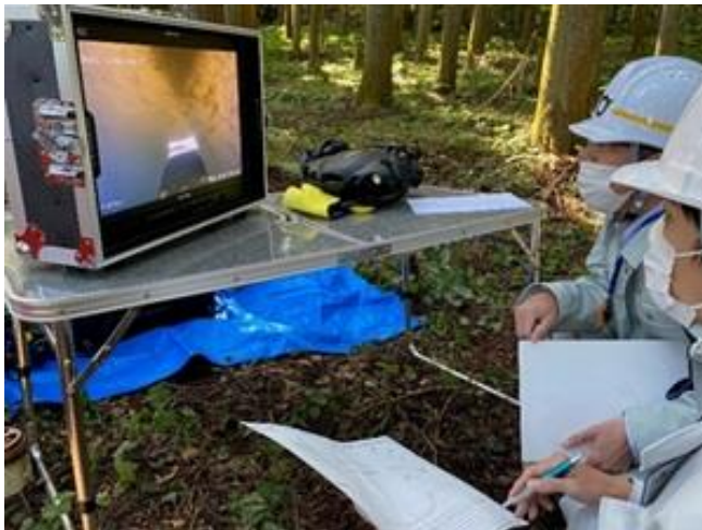
機能診断調査の状況 (水中ドローンによる管内調査)
