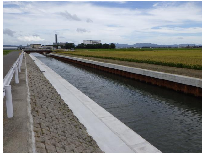
国土強靱化対策 (排水路改修)
