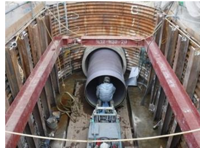
施設規模の適切化 (施設更新に併せた管径のダウンサイジング)
