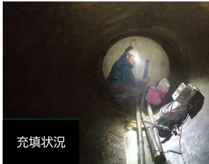
管内作業(別工事)
