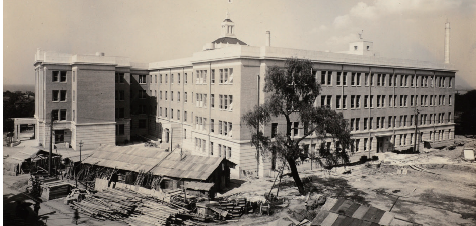
本館を南側から見る（新館建設前）
