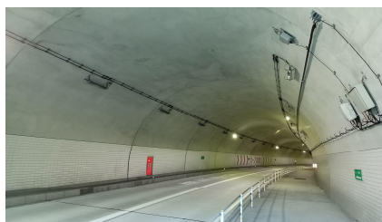
トンネル内 LED照明に交換
