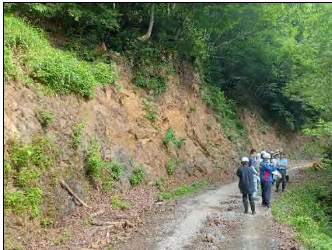
写真 合同現地調査状況（令和8年6月15日）
