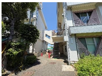
スロープのない連絡通路
