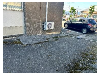
地盤沈下により建物周辺や建物内部に段差が発生
