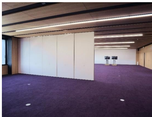
● 図表6 間仕切り可能な会議室 (千葉県山武合同庁舎)
