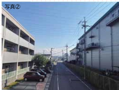
手原蜂屋変電所線(令和7年11月17日撮影)
