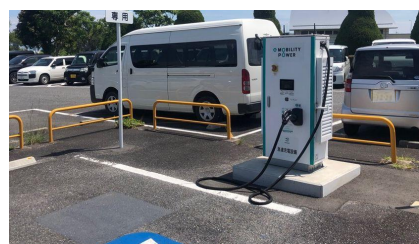
道の駅にEV急速充電器の設置
