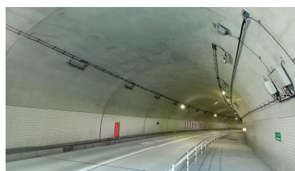
トンネル内 LED照明に交換
