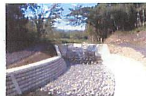
溪流保全工と床固工
