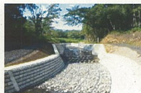
溪流保全工と床固工
