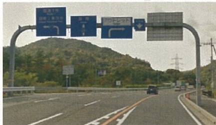
門型標識（国道477号_竜王町）
