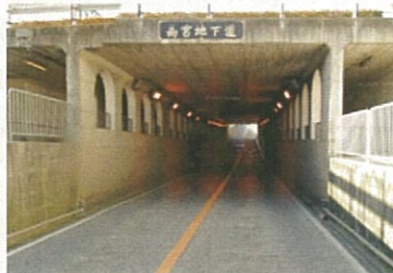
大型カルバート（高宮地下道_彦根市）
