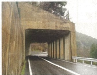
ロックシェッド（国道477号_甲賀市土山町）
