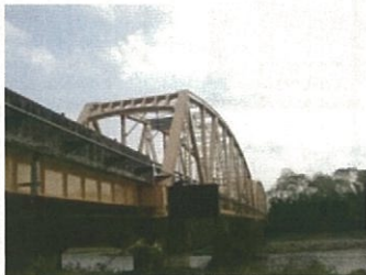
橋梁（安曇川大橋_高島市）
