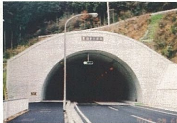
トンネル（裏白トンネル_甲賀市信楽町）
