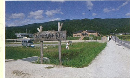
高時小学校(長浜市)のビオトープ兼用の雨水貯留施設
