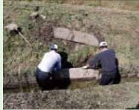
排水路の補修
