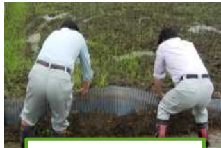
波板を押し込む
