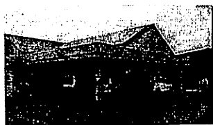
⑩コナン市民共同発電所 初号機 (障害者支援施設「パンパン」)
