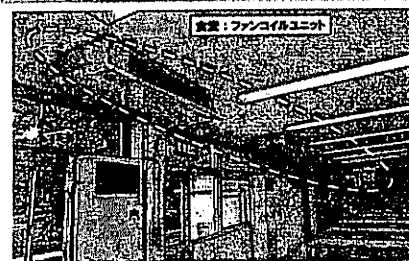
食堂ホールの空調補助として
