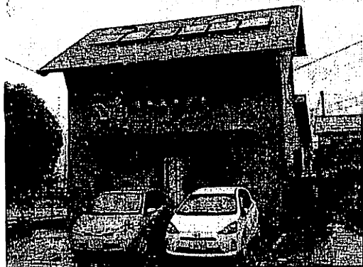
屋根に設置された太陽熱集熱パネル
