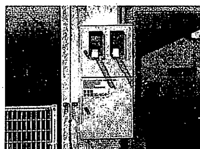
災害時非常用コンセント
