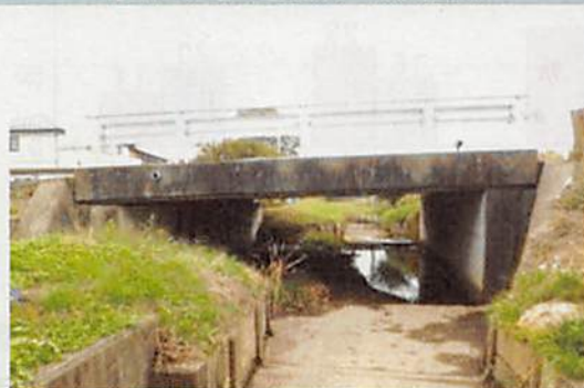
[写真 1] 道路橋 (桁形式)
