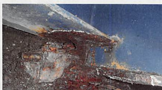
桁端部の腐食（サビ）部の補強
