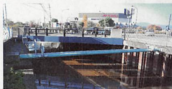
殿田川橋（鋼桁橋） 大津草津線 草津市新浜町
