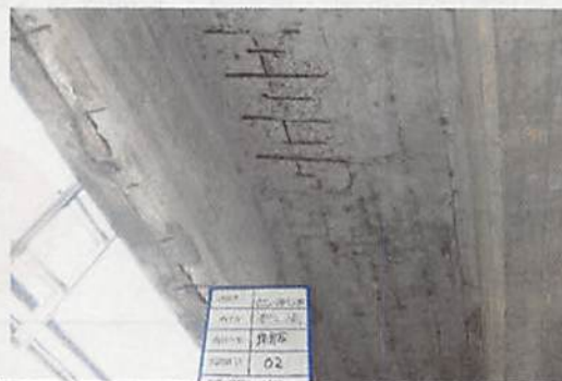
コンクリートの剥離、鉄筋露出部分の修復
