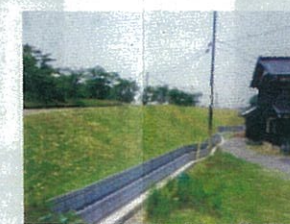
祖父川(堤防排水工)
