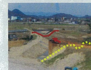
家棟川(由良谷川)(放水路整備中)
