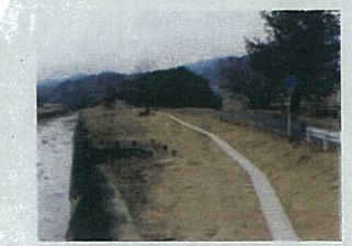
祖父川(遮水矢板工)
