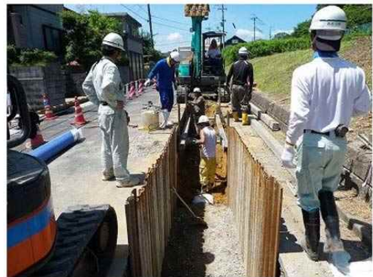
図 3-1-9. 下水管の布設状況
