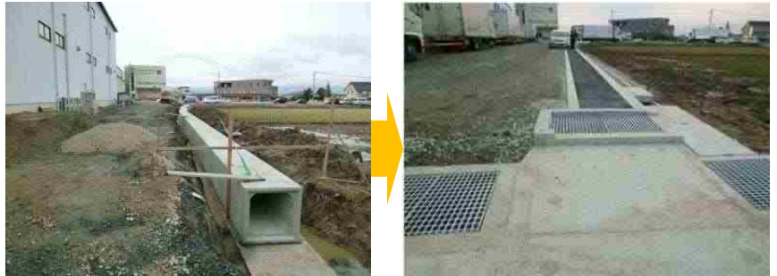
図 3-2-7. 守山市雨水渠の整備（施工中、完了）
