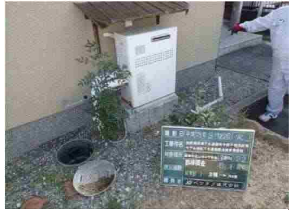
図 3-2-17. 不明水発生箇所の調査状況
