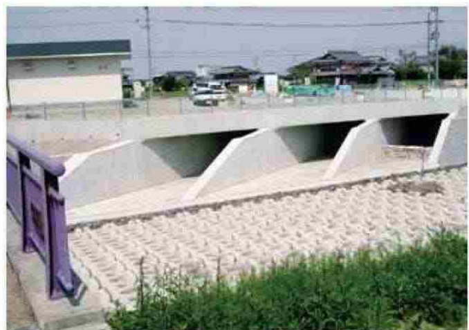
図 3-2-9. 守山栗東雨水幹線（新守山川放流部）
