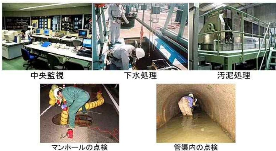
図 3-2-44. 下水道施設の管理状況
