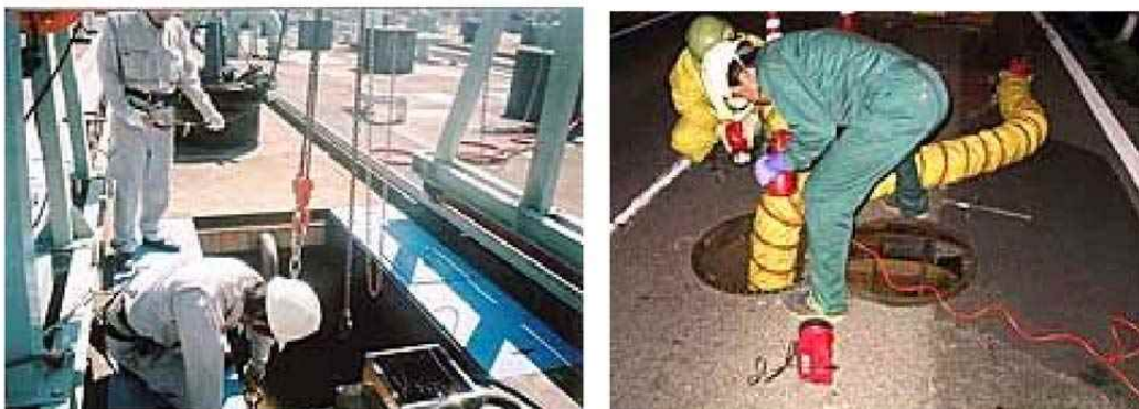
図 3-2-46. 処理場、管路の点検・調査状況
