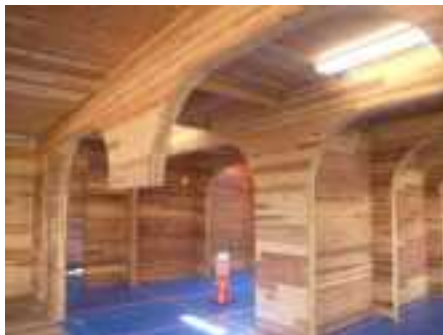
県内でCLTを活用して建設される事務所棟
