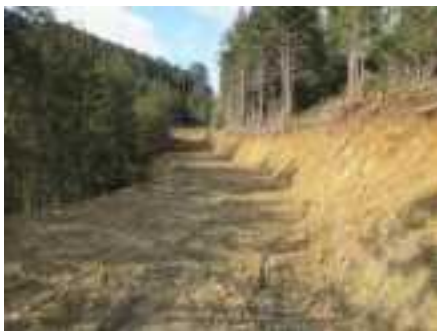
間伐材搬出道
