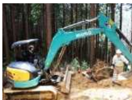
作業道作設研修
