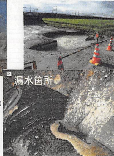
漏水による周辺陥没状況
