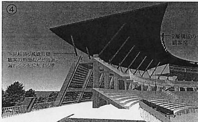
南サイドスタンド側スタジアムリングから:檜(やぐら)形状の建物構成
