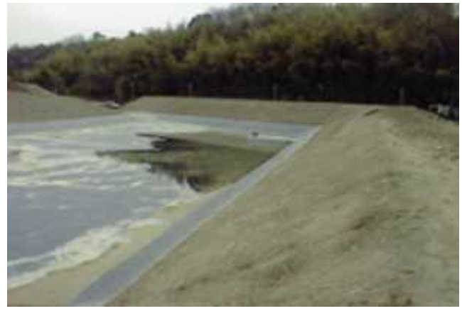
④ 沈砂池の設置 (平成 14 年 11 月完了)
