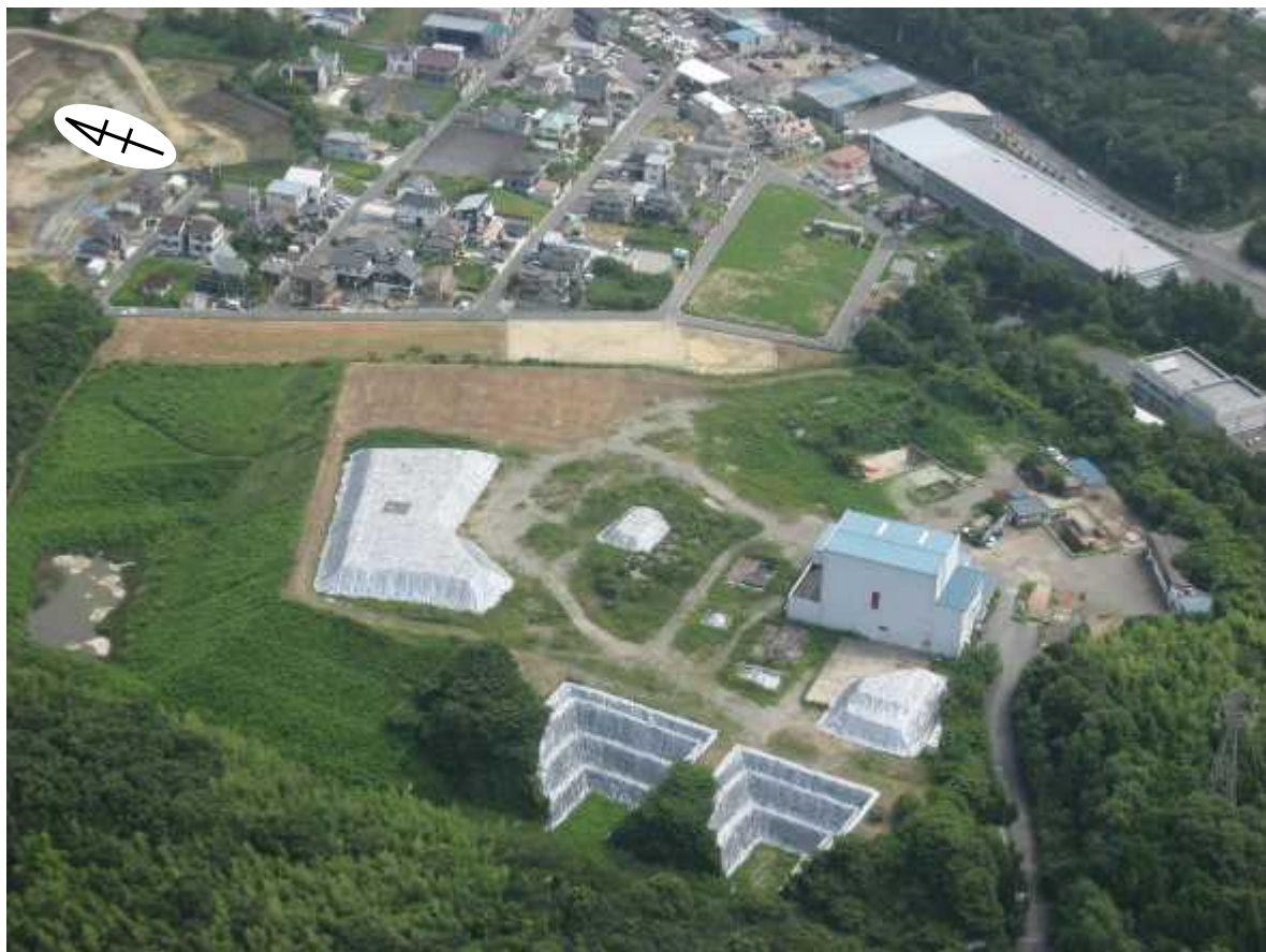
図 1-3 処分場全景（平成 22 年航空写真）
