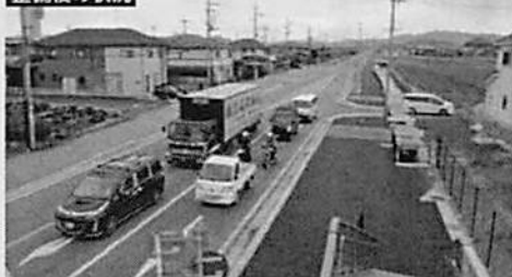
整備後の状況
