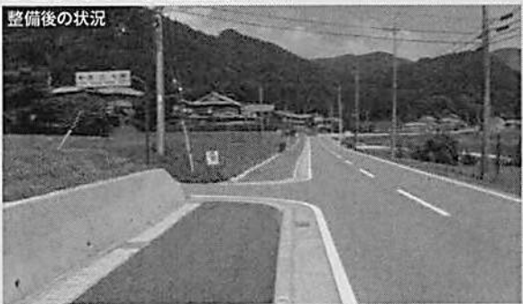
整備後の状況
