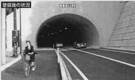
整備後の状況
