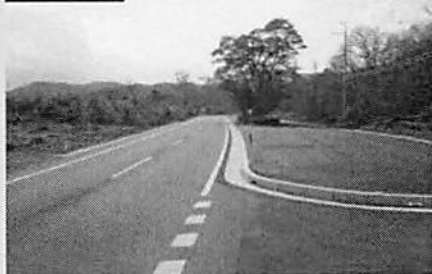
整備後の状況
