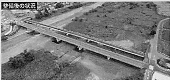
整備後の状況
