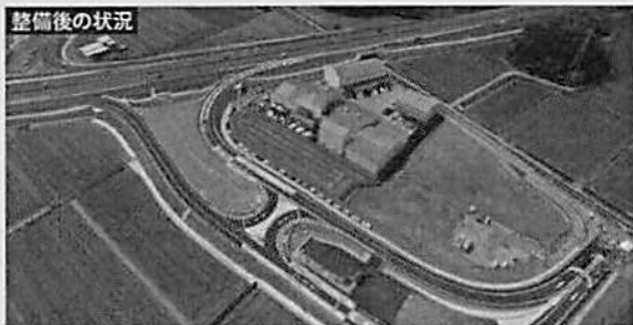
整備後の状況
