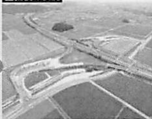
整備後の状況
