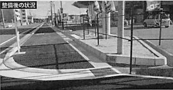
整備後の状況
