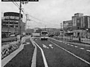
整備後の状況
