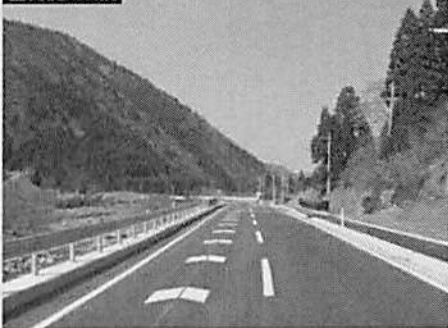
整備後の状況
