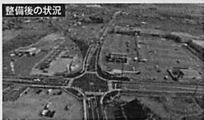
整備後の状況
