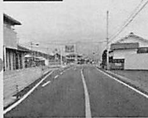
整備後の状況
