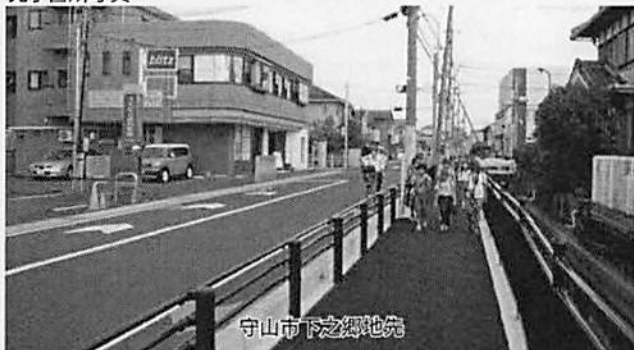
完了箇所写真
