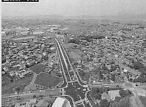
整備後の状況
