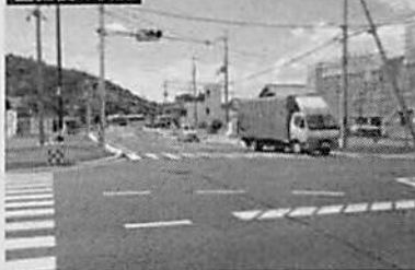
整備後の状況
