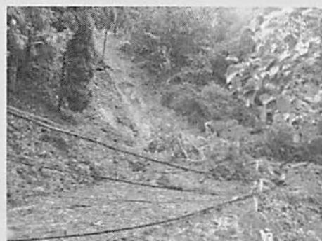
平成29年10月台風21号による国道367号(坂根地区)の被災状況
