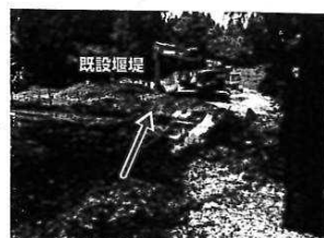
土砂撤去状況(7月2日から着手)
