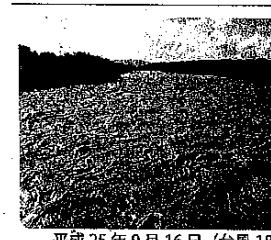
平成25年9月16日(台風18号) 安曇川大橋付近 写真提供: 滋賀県
