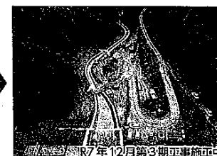
R7年12月第3期工事施工中
