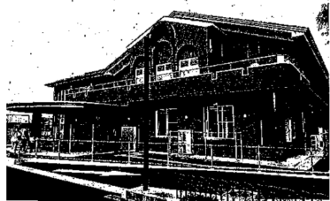
改修工事が完了し、10月1日に開園した「北里くじらこども園」
